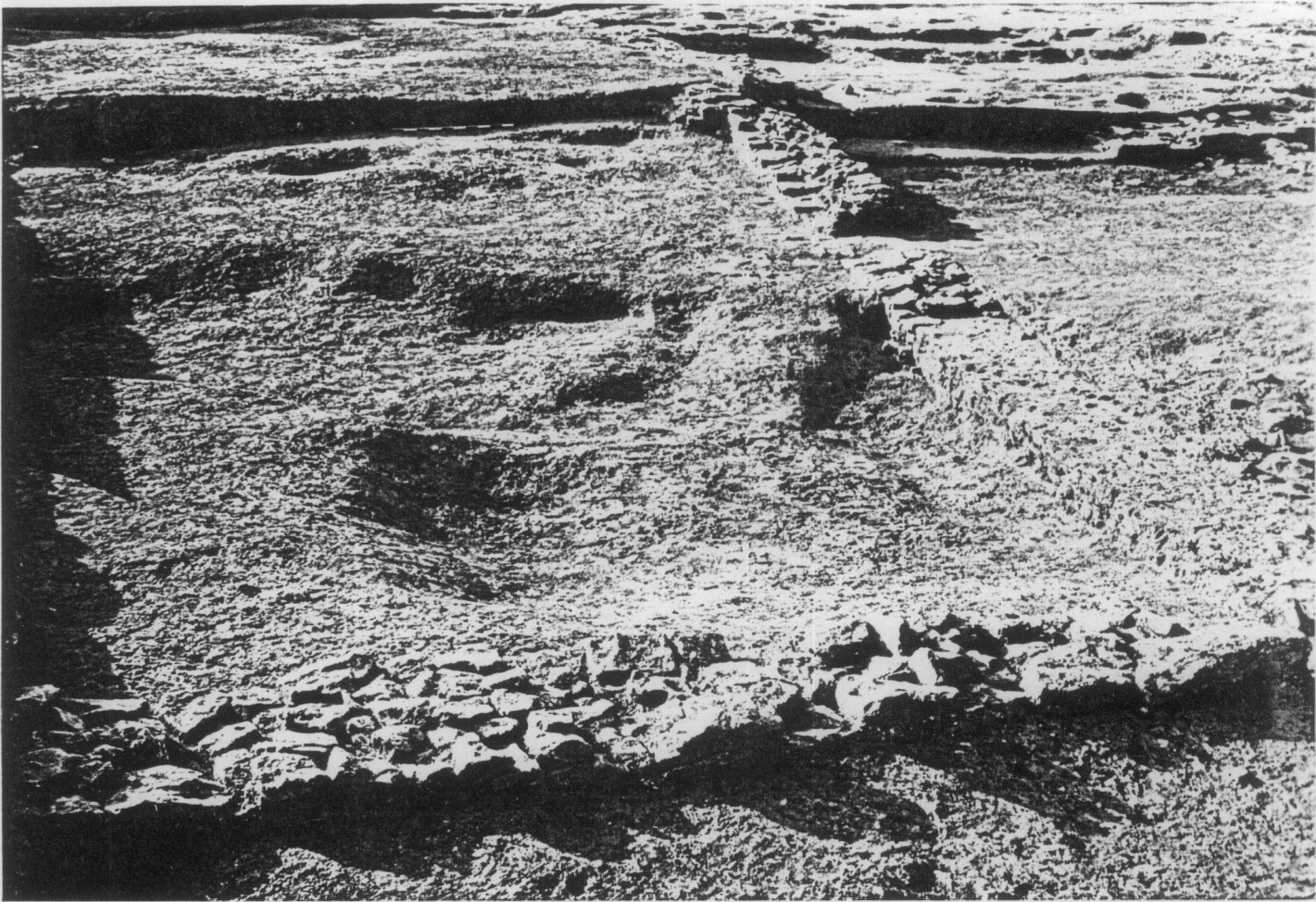
65. L'arrière (n°18.2) de la maison 18, vu du S.E.
