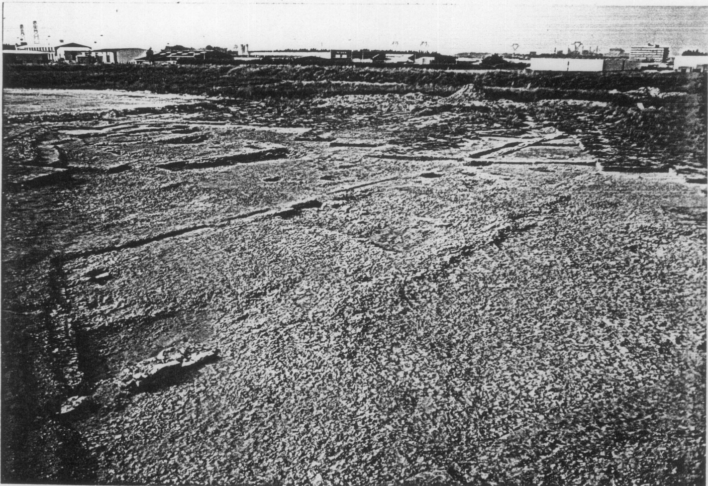
3. Vue générale de la moitié nord du chantier d'été, prise du S.E.
