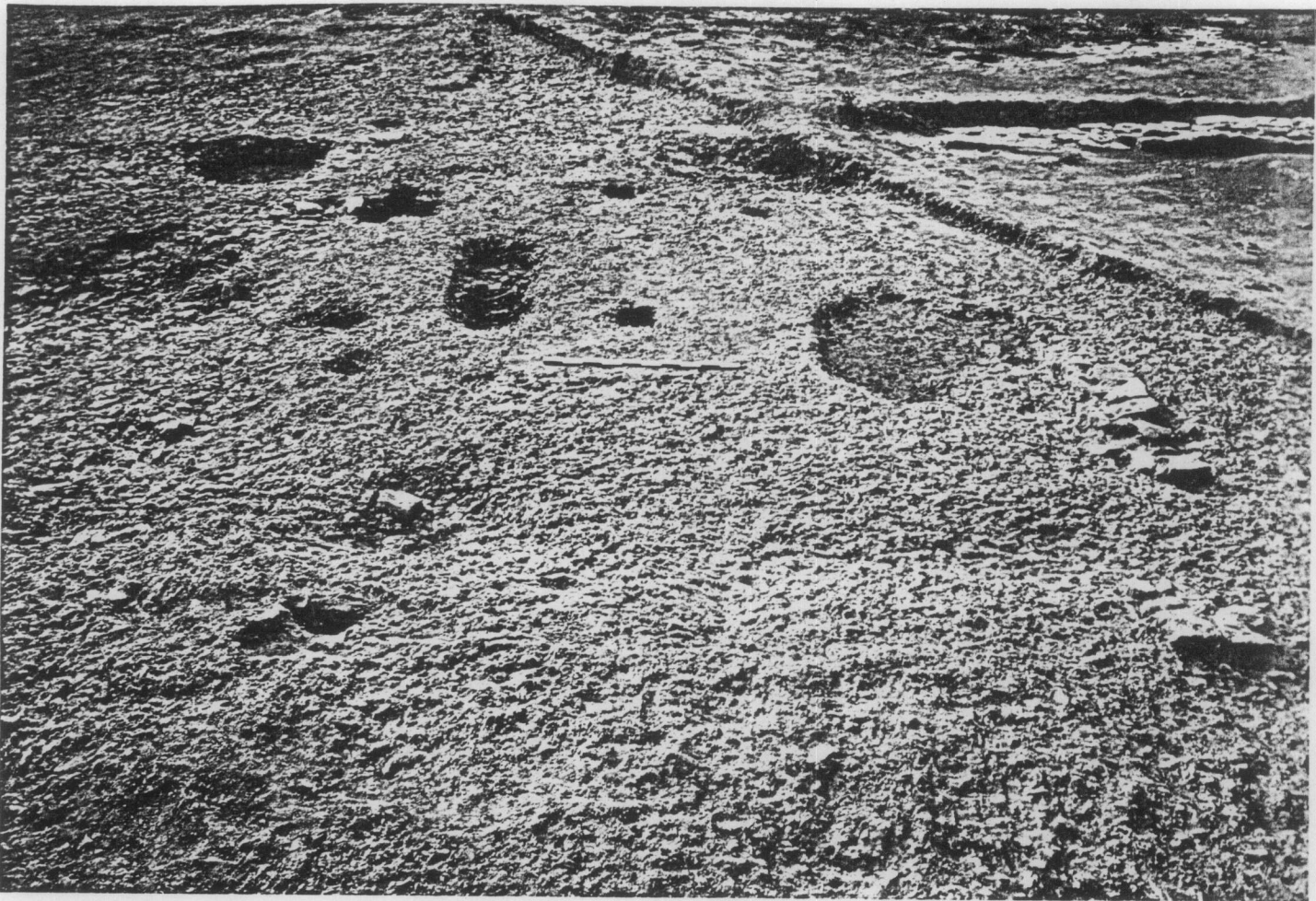
81. Le bâtiment 22, vu du S.E.
